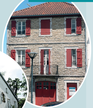
Création de logements sociaux dans du bâti existant
